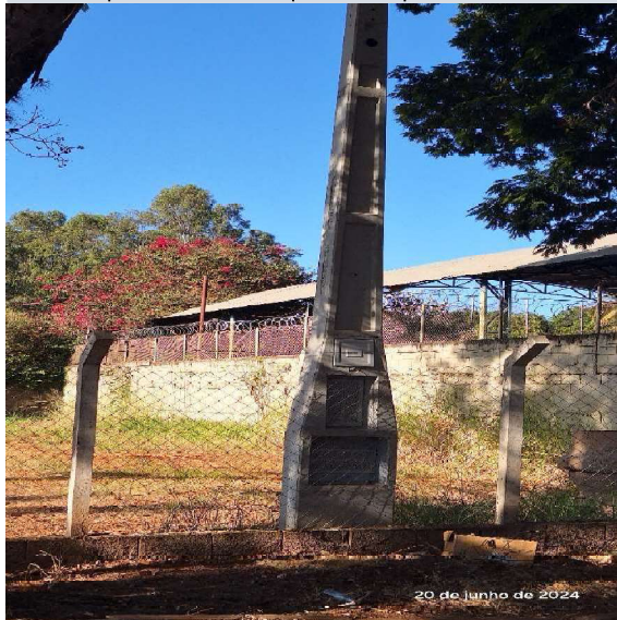
Poste para Ligação de Energia Instalado
