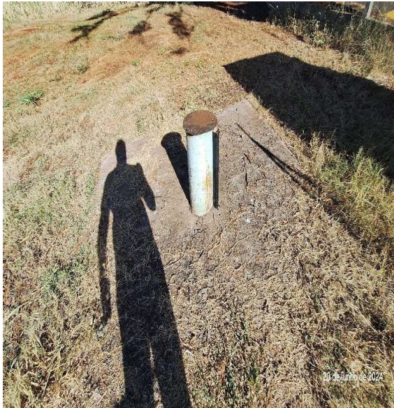
Poço para captação de água sem bomba
