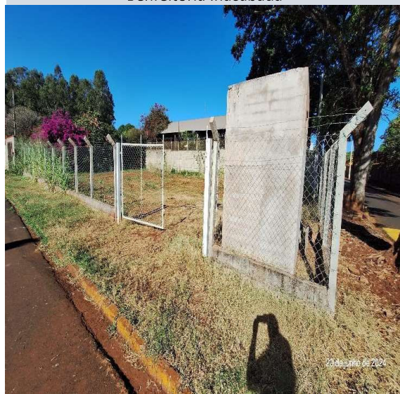
Entrada do terreno avaliado
