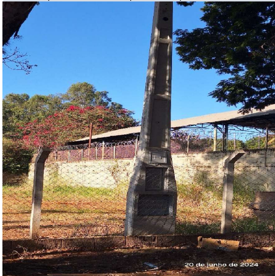
Poste para Ligação de Energia Instalado
